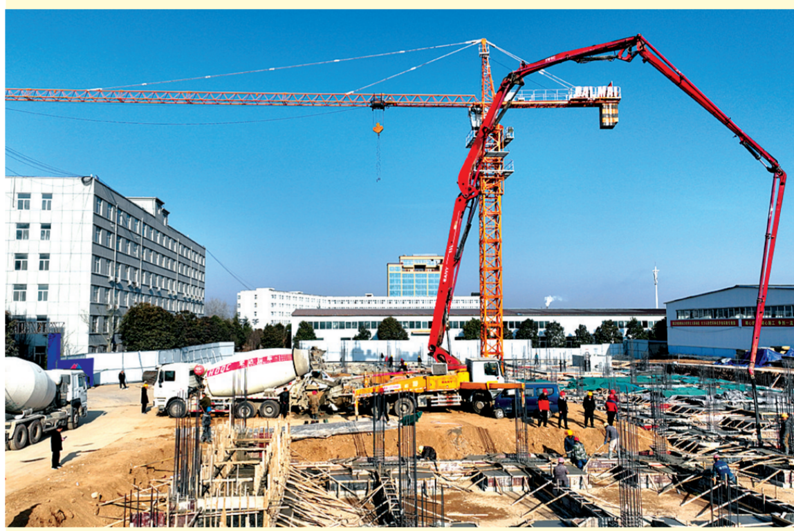
1月5日,在灵宝市先进制造业产业园内,施工工人正在给三门峡黄金精深加工产业园项目浇筑水泥夯实地基。
