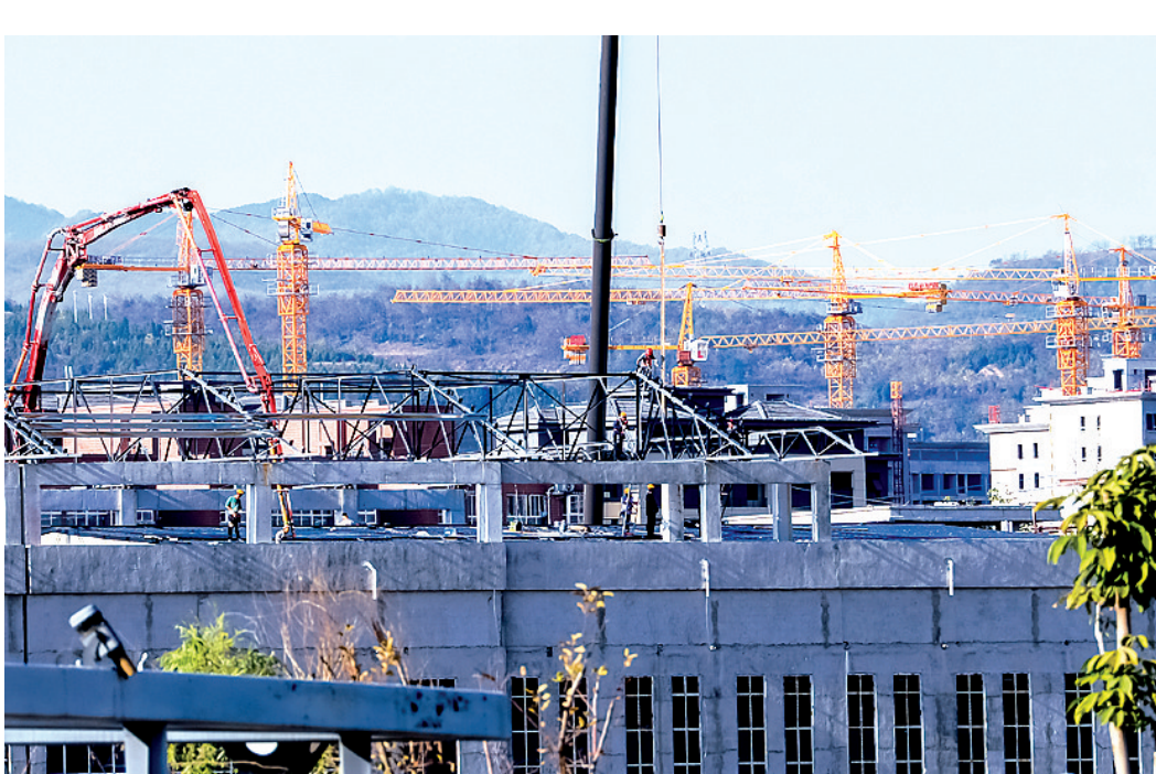
10月30日,在卢氏县棚户区改造工程施工工地,塔吊林立,工人们在忙碌施工。卢氏县清华西路(寨子村)棚户区改造项目住宅为剪力墙结构,裙房、车库为框架结构,建筑用地面积约5.6万平方米,总建筑面积21.1万平方米,其中,地上总建筑面积16.3万平方米,地下总建筑面积4.8万平方米,是卢氏县最大的民生改造建设项目。该项目建成后,将提供1100余套住宅,解决周边4000余人的住房问题。李东阳 摄
